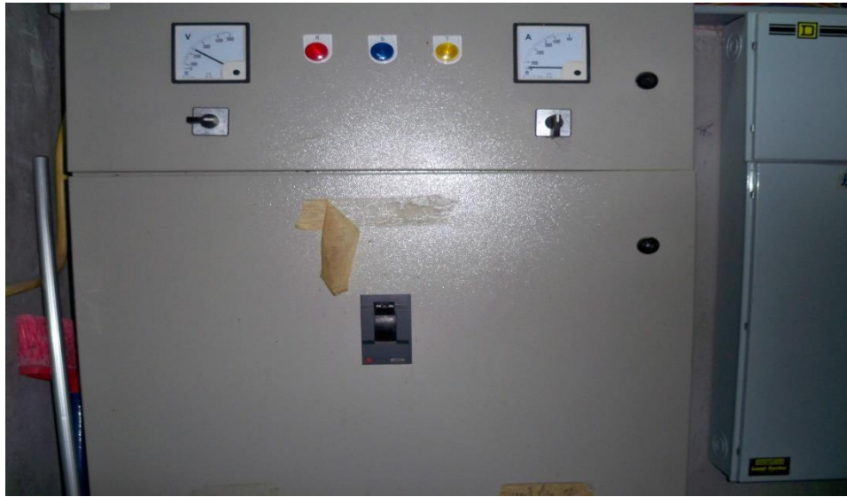
ตู้เมนส์ควบคุมไฟฟ้าชั้น 6
